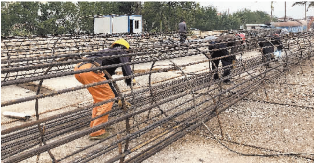
工人正在进行桩位钢筋的焊接作业。记者 洪艳艳 摄 P194155664
