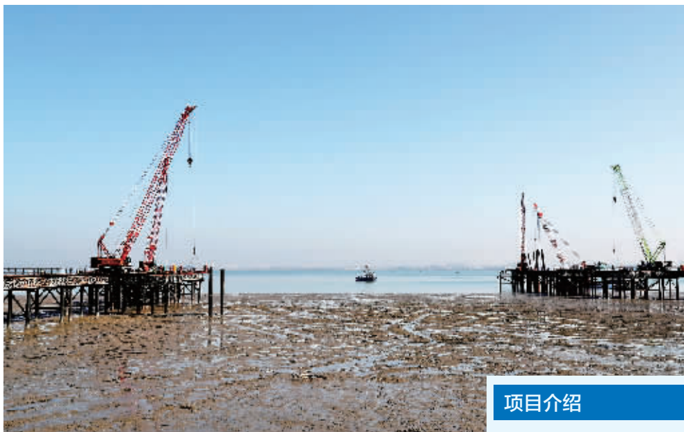
钢栈桥与海上平台正在如火如荼建设中。 记者 白焯焯 摄 P19B177324
