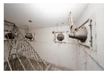
钟楼第五层电机控制着大钟四个方位的指针,第三、第四层各个方位装喇叭。记者 陈理杰 摄 P19C192562
