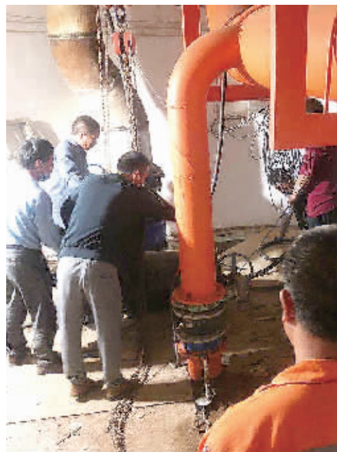
桥隧中心工作人员在操作潜水排污泵。
