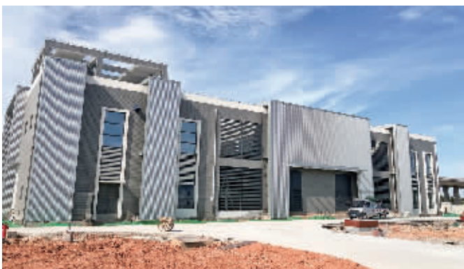
7月3日晚,厦门地铁3号线蔡厝主变电所成功送电。 通讯员供图
