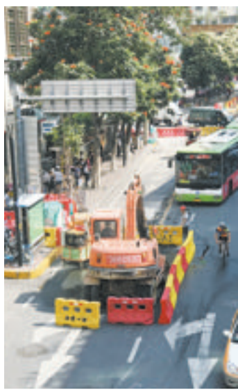
厦禾路莲富大厦段雨水主管改造破路施工。
