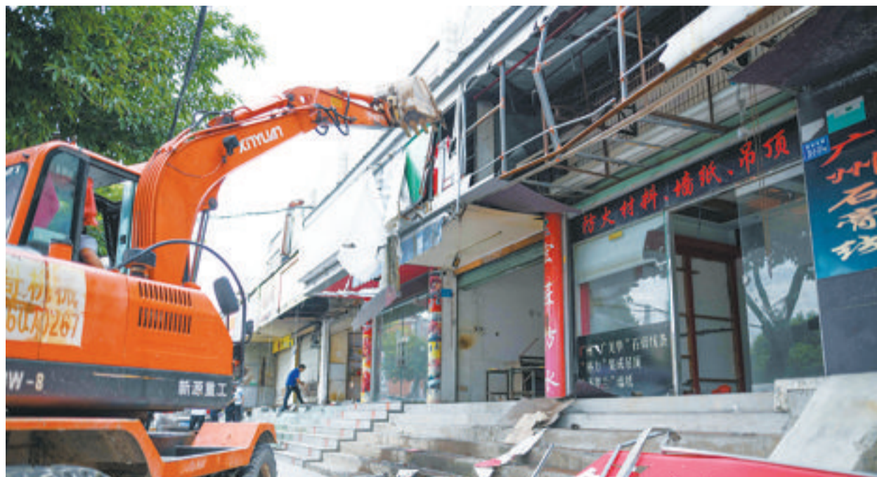
▲出动挖掘机,拆除店面招牌。
