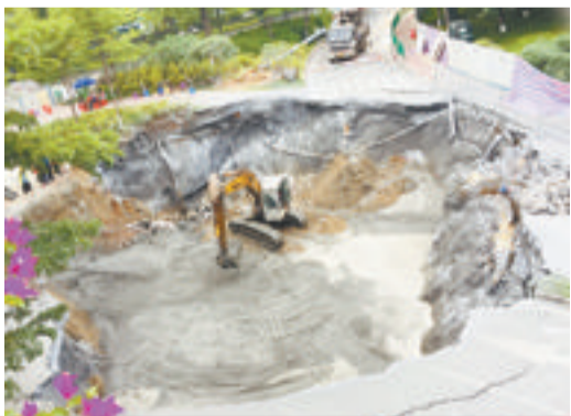
昨日下午六点左右挖掘机用机械臂回填混凝土。(施工方供图)
