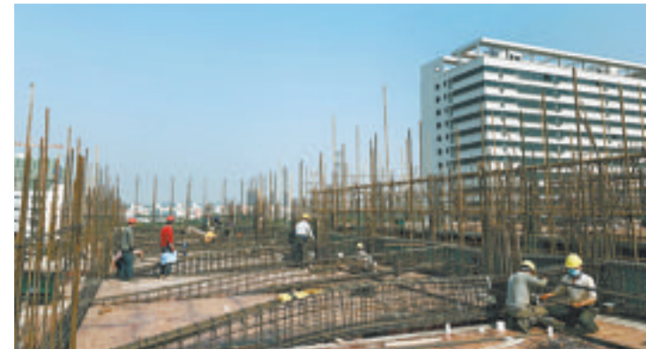
翔安水厂二期工程项目,工人正在加紧施工。
