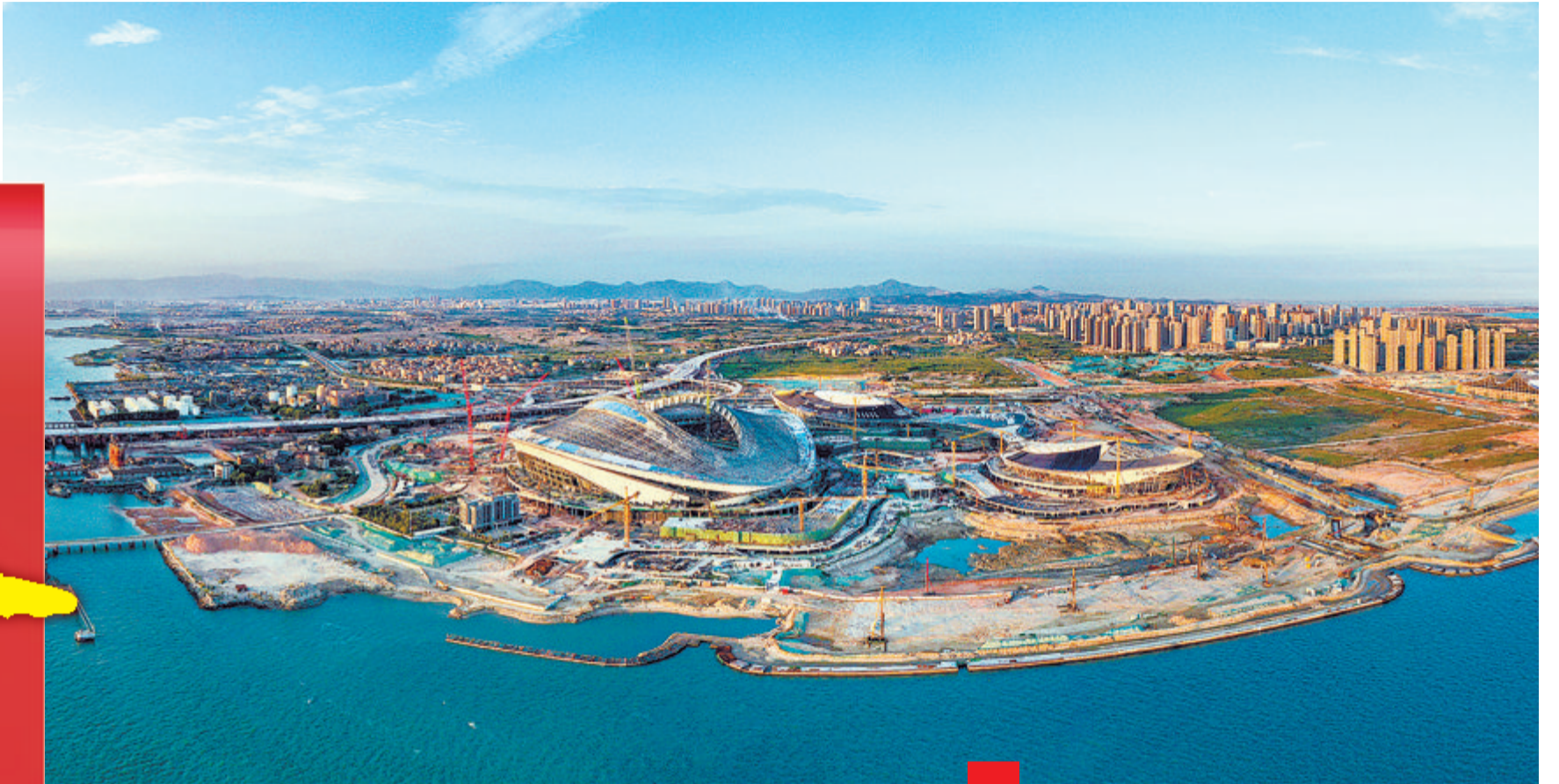
市发改委以更高的站位、更实的举措,全方位推进厦门高质量发展超越。图为建设中的新体育中心和会展中心。(本报记者 王火炎 航拍摄)
