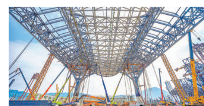
福厦高铁站正在建设中。(市发改委供图)
