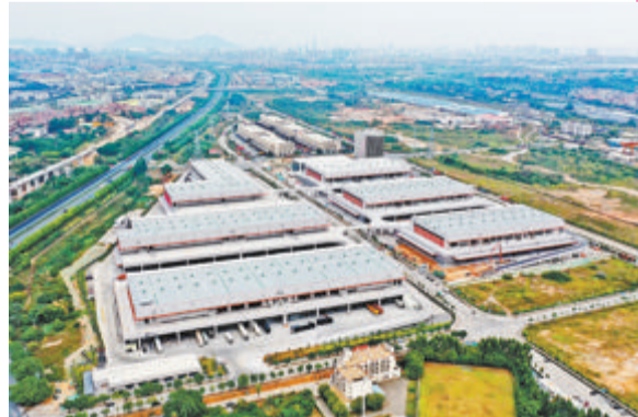
不久前，总投资13亿元的前场片区东南智慧供应链产业园部分园区（北区）率先投入试运营，第一批签约商户已入驻园区。
