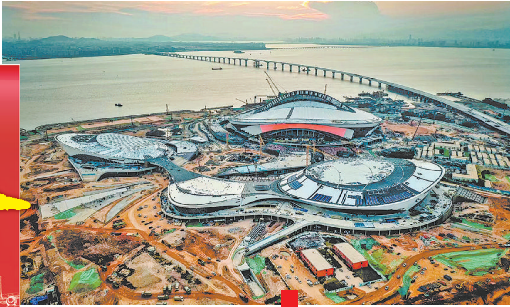
新体育中心一场两馆建设如火如荼、捷报频传。目前，白鹭体育场屋面施工迈入收尾阶段。
