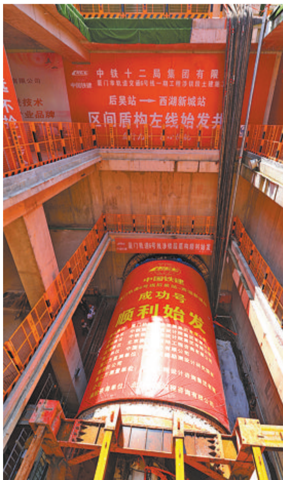
▲7月22日,厦门地铁6号线集美至同安段涉铁区间正式进入盾构掘进施工阶段。
