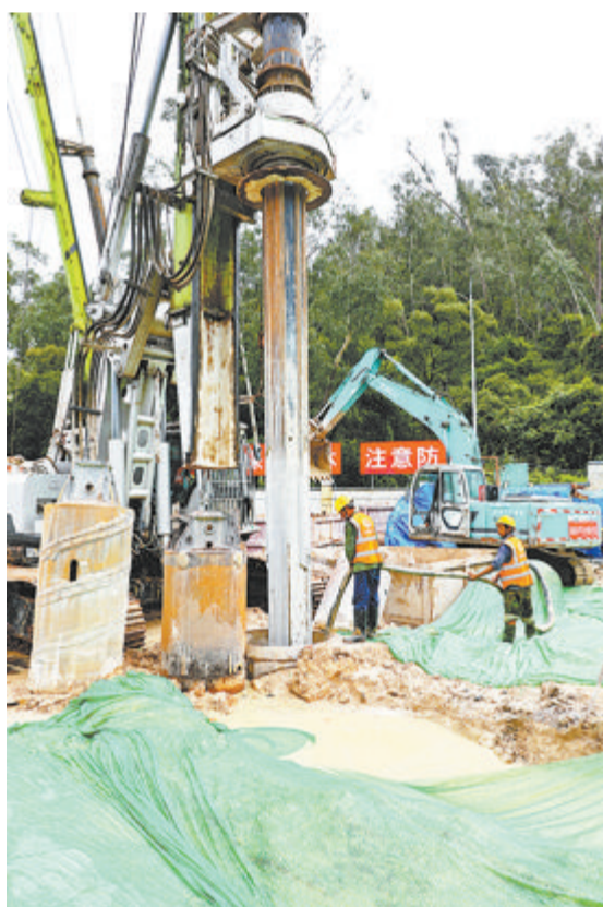
▲6月17日,厦门地铁最深风井——3号线南延段(上厦区间)中间风井完成钻孔灌注桩施工。
