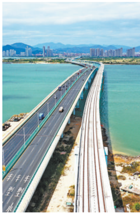
▲厦门地铁4号线(在建)为岛外环线快线,图为4号线高架桥横跨同安湾海域。
