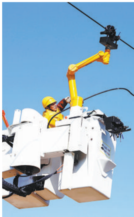
2021年1月,福建省内首台单臂人机协同配网带电作业机器人带电作业在厦门“首秀”。(杨帆摄)
