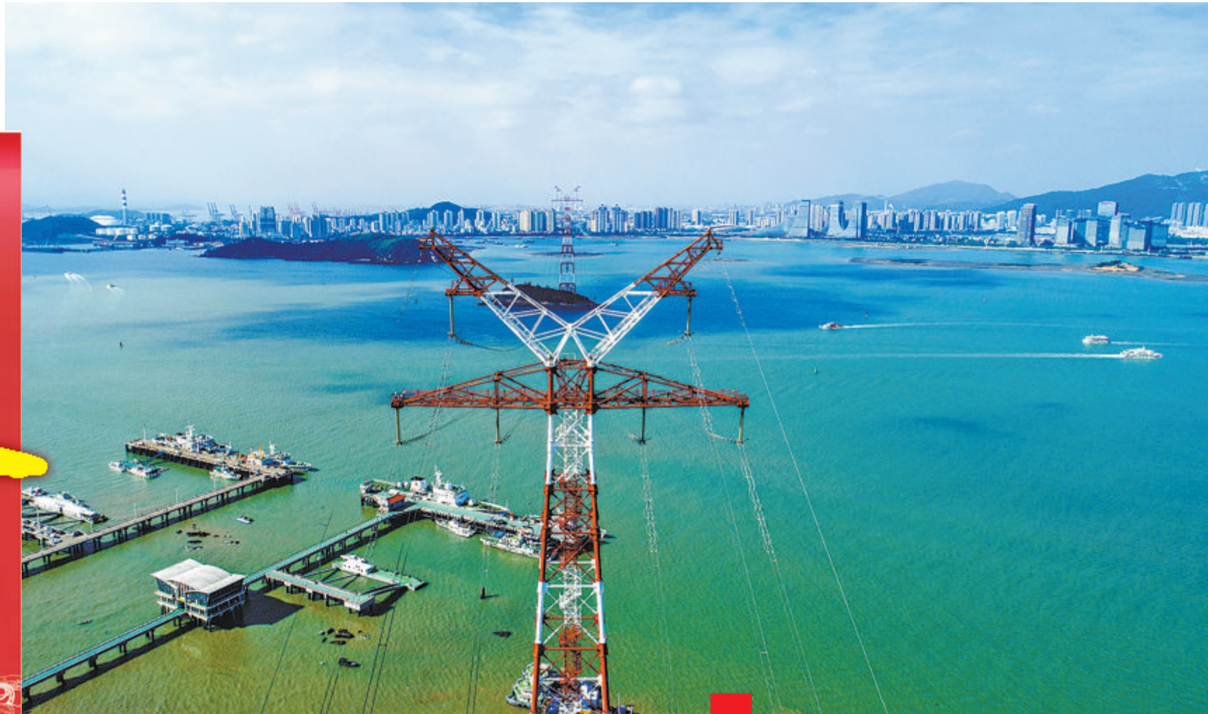
“坚强电网”点亮了万家灯火,驱动着生产齿轮,服务厦门全方位推进高质量发展超越。图为厦门电网跨海通道。(国网厦门供电公司供图)
