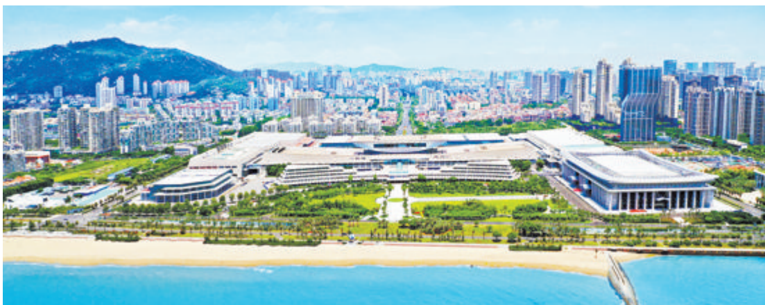
▲建发集团通过高品质服务助力厦门旅游文化会展万亿产业集群发展。图为厦门国际会展中心。
