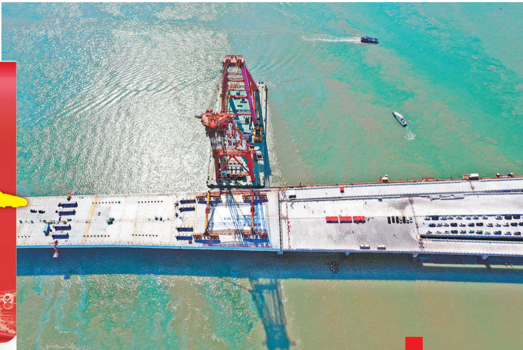
9月12日，翔安大桥跨海主桥正式合龙。 (本报记者 王协云 航拍器摄)
