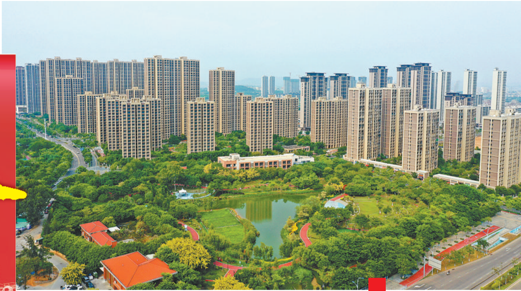
我市持续优化完善住房保障体系,稳步提升住房保障能力。图为洋唐居住区。(本报记者 王协云 航拍器摄)
