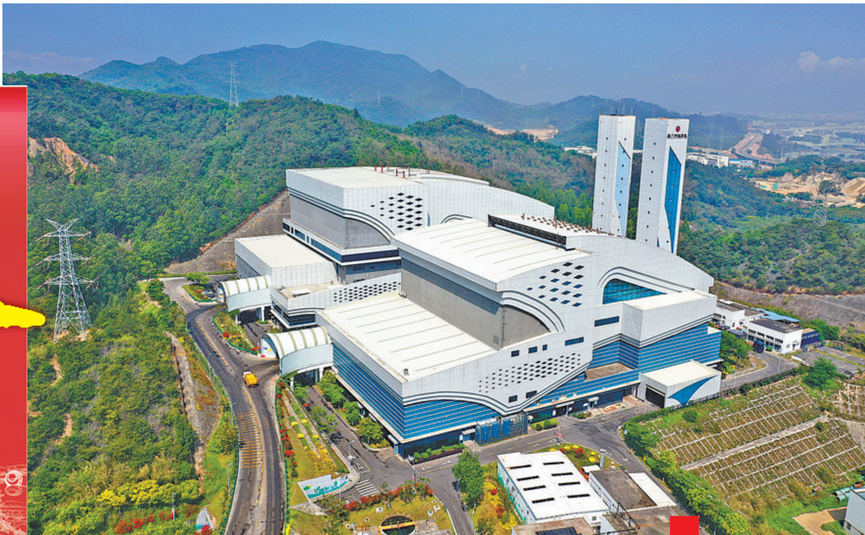
我市持续完善垃圾分类 末端处理设施。图为海沧生 活垃圾焚烧发电厂。 (本报记者 王协云 摄)
