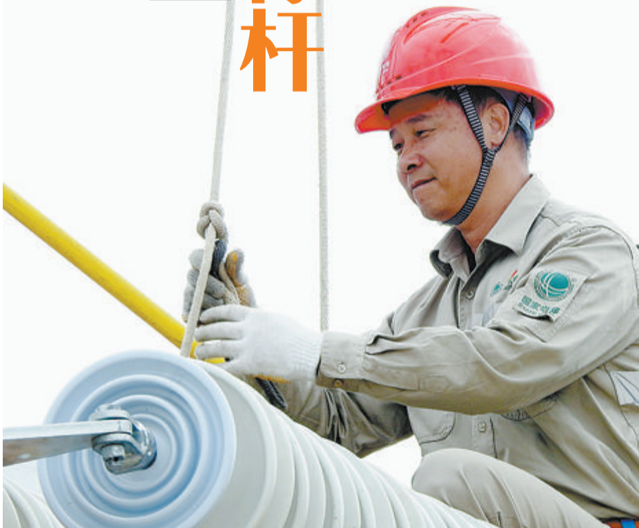
陈国信在输电线路杆塔上进行更换绝缘子作业。(受访者供图)
