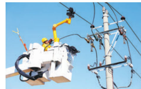
配网带电作业“机器人”上线作业,厦门配电网带电作业水平再提升。(杨帆 摄)
