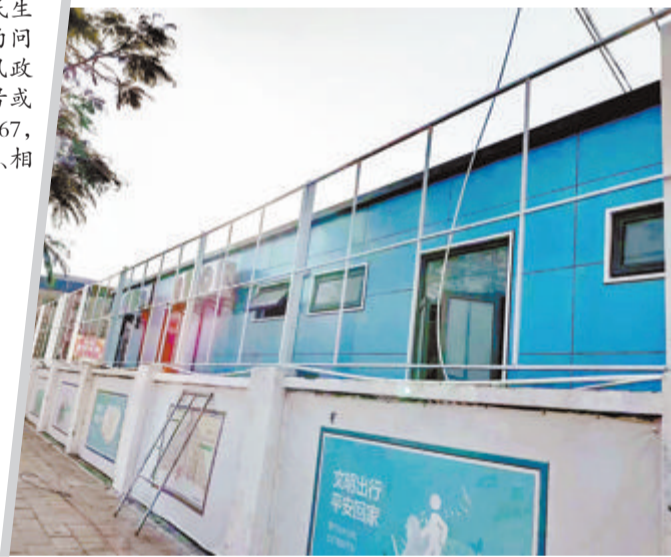
▲正在施工加高的公厕围墙。(厦门天地集团 提供)
