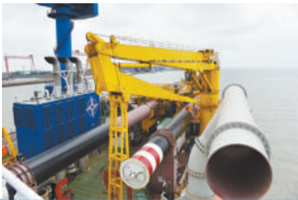
「天鲲号」船头安装的钢桩
