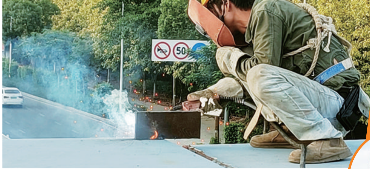
国道324复线同安段项目施工方
