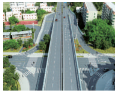
环岛干道施工路段
