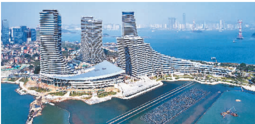
厦门甲级写字楼市场进入“存量时代”。
