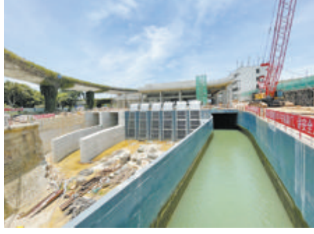
筓筓湖第二排涝泵站及西堤闸工程现场。
