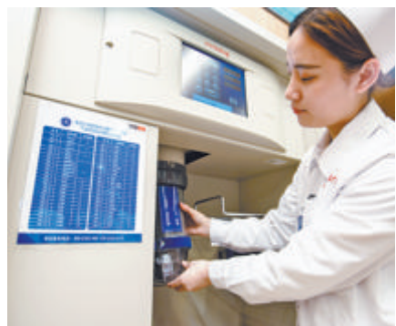
▲复旦中山厦门医院在厦率先启用先进的气动物流传输系统,药品从药房到病房只需几十秒钟。(资料图片)
