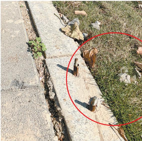
该路段步行道靠绿化带处凸起的螺丝钉。
