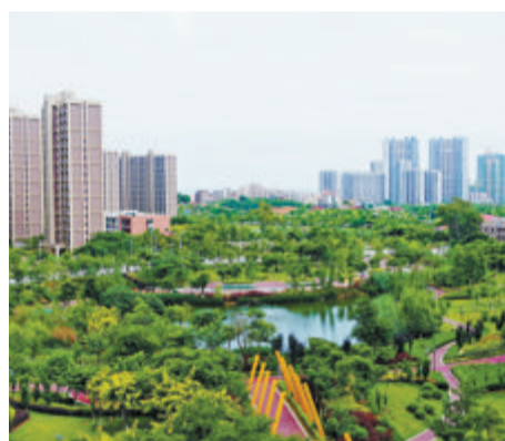
▲我市持续推进海绵城市建设，提升水资源利用率。图为海绵公园——翔安鼓锣公园。(资料图)
