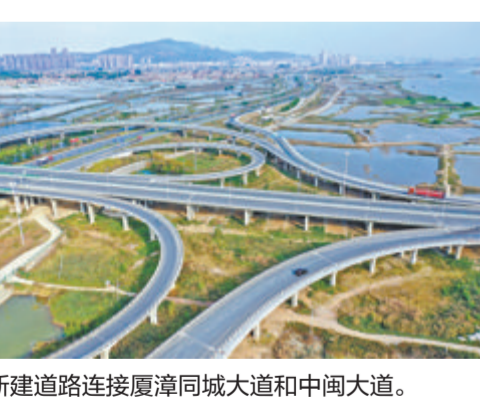
新建道路连接厦漳同城大道和中闽大道。
