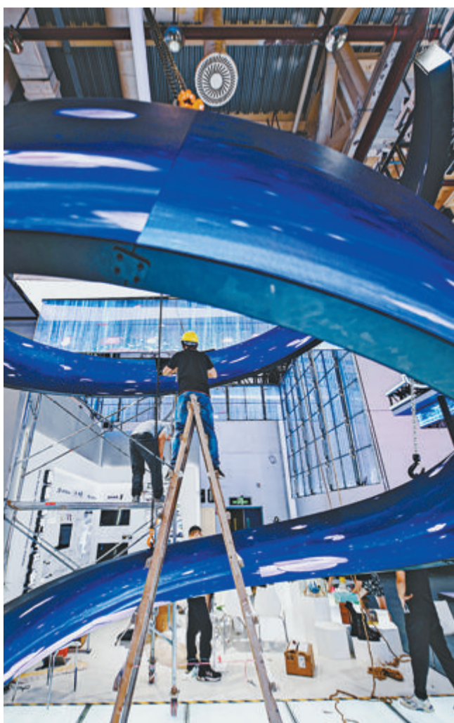
▲现场展台进行最后的安装工作。
