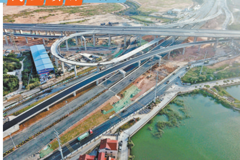
溪东路A标完成翔安南路主车道交通导改。(市交通执法支队质安大队 供图)
