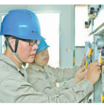
▲新能源科技公司施工作业人员在施工现场进行检查。
