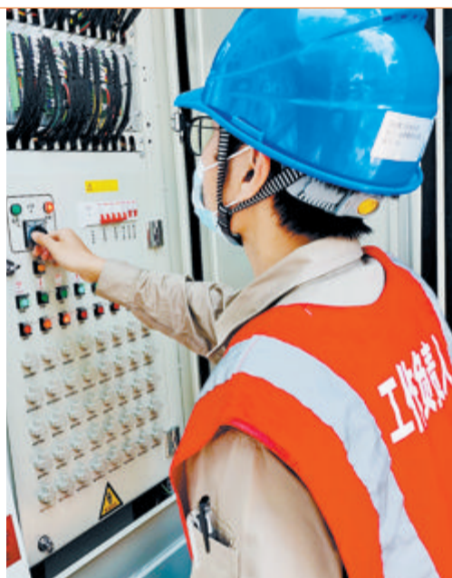
▲远通公司作业人员在现场进行配网终端自动化调试。
