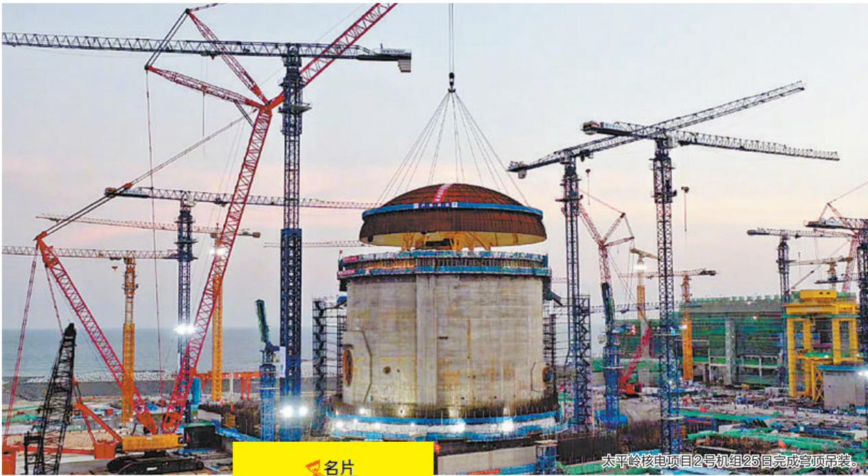
太平岭核电项目2号机组25日完成穹顶吊装。
