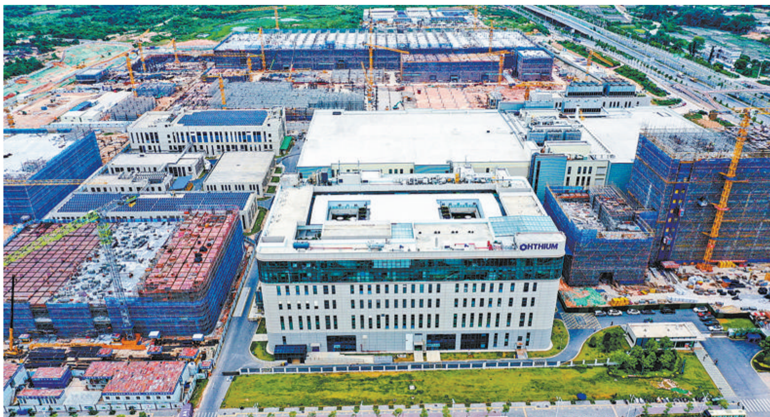
同翔高新城片区内正在建设的海辰储能二期项目。
