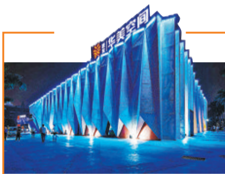
湖里老工业区综合改造，实现特区记忆向现代文创产业园的完美变身。
