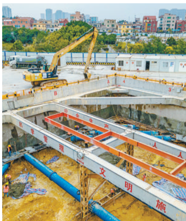
▲厦门市城市建设投资基金将积极参与厦门重点基础设施项目和重大产业投资项目。图为厦门轨道交通6号线集美至同安段涉铁工程区间。(资料图)
