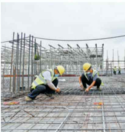
在美亚柏科智慧城市创新中心项目施工现场,假期仍是忙碌景象。
