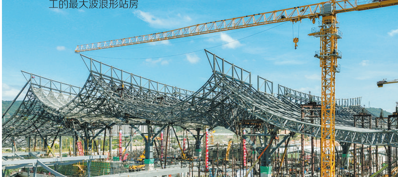
新建厦门北站主站房钢屋盖合龙。
