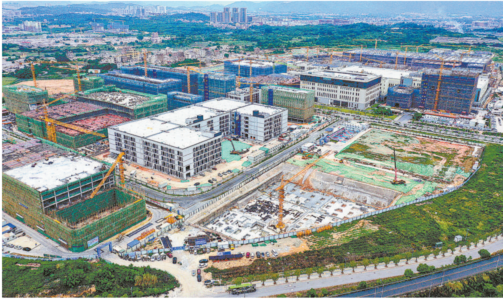
正在如火如荼加速建设的同翔高新城一角。(本报记者 张奇辉 摄)
