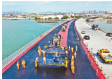
工人正在进行浇注式沥青铺设作业。(本报记者 王协云 摄)
