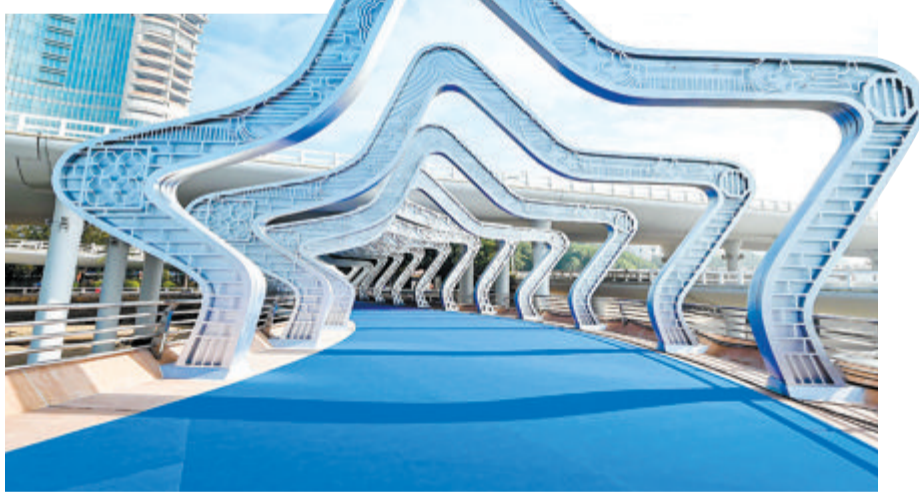
星光通道由12组星光造型的门廊组成。
