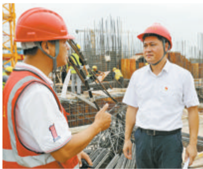
陈聪艺（右）到项目工地与工程负责人研究施工进度情况。
