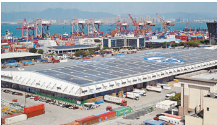
象屿综合保税区内成片的仓库屋顶铺设了光伏发电板。(本报记者 黄晓珍 摄)
