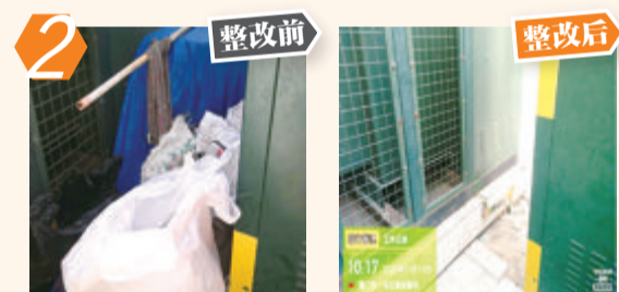
2 整改前 整改后 湖里区乌石浦二里193号乱堆杂物问题。经现场核查,该问题已完成整改。
