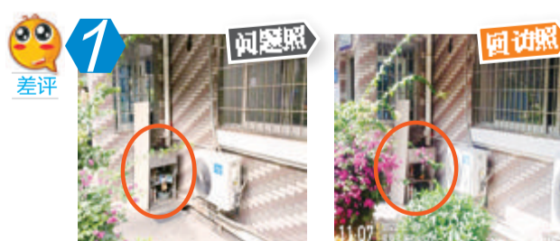
1 问题照 回访照 思明区万寿北里118-1号乱设置户外水池问题。经现场核查,该问题未整改。
