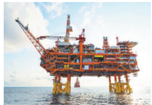
恩平15-1海上石油生产平台
