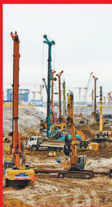
▲地铁3、4号线机场西站正在进行基坑围护结构钻孔灌注桩及上部开发预留桩基施工。
