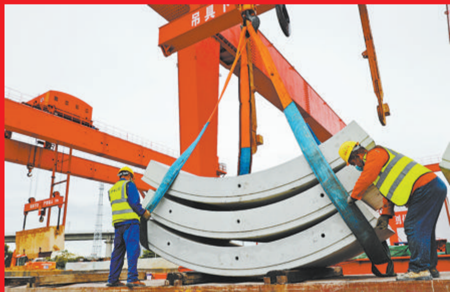
▲在地铁工人的配合下，巨大的龙门吊正在吊装盾构施工的管片。图为地铁6号线集同段工程涉铁区间风井施工现场。
