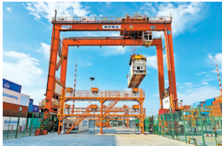
▲海天集装箱码头冷场一台龙门吊在进行吊冷危集装箱作业。
