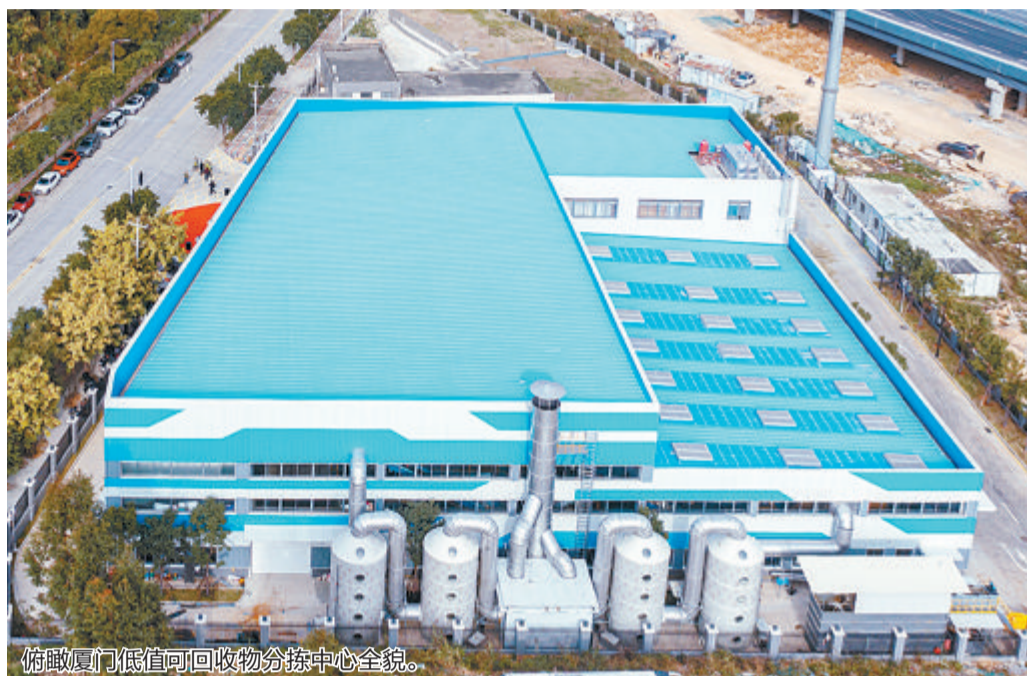
俯瞰厦门低值可回收物分拣中心全貌。
